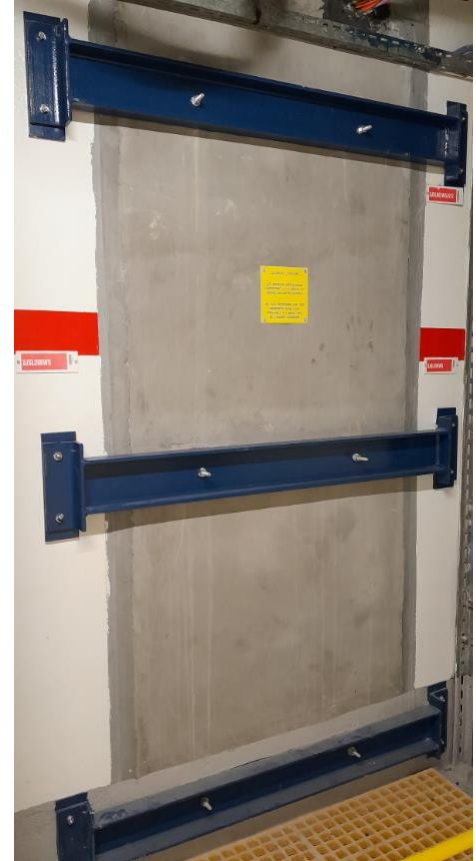
Verstärkung der Trennwände
