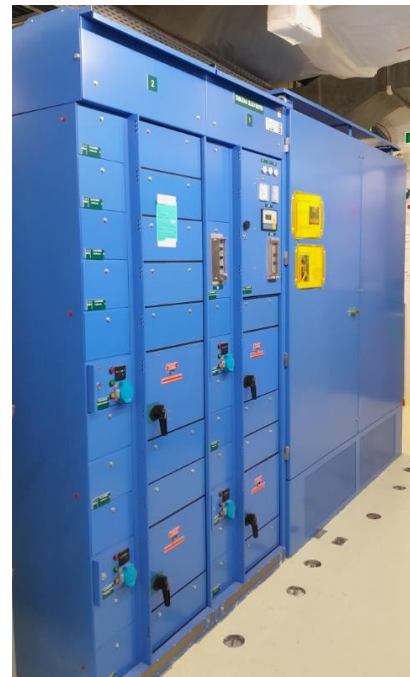
Neuer Transformator 6,6 kV / 380 V für die Versorgung des Kernbereichs
