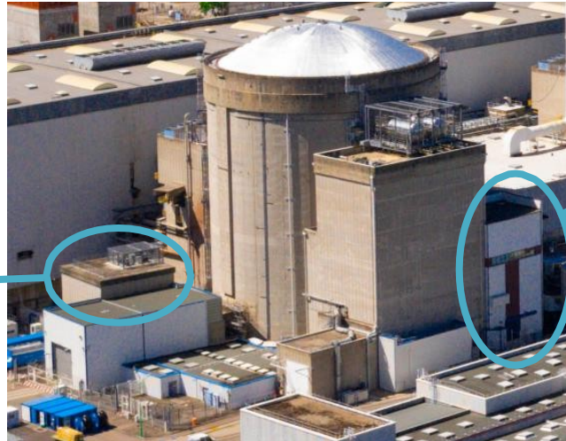
Schutz vor dem „Hard Core“-Tornado: Foto der aktuellen Anlage und Prinzipskizze der Verstärkungen der Dachkonstruktion (durch Netzplatten oder Gitterplatten).
