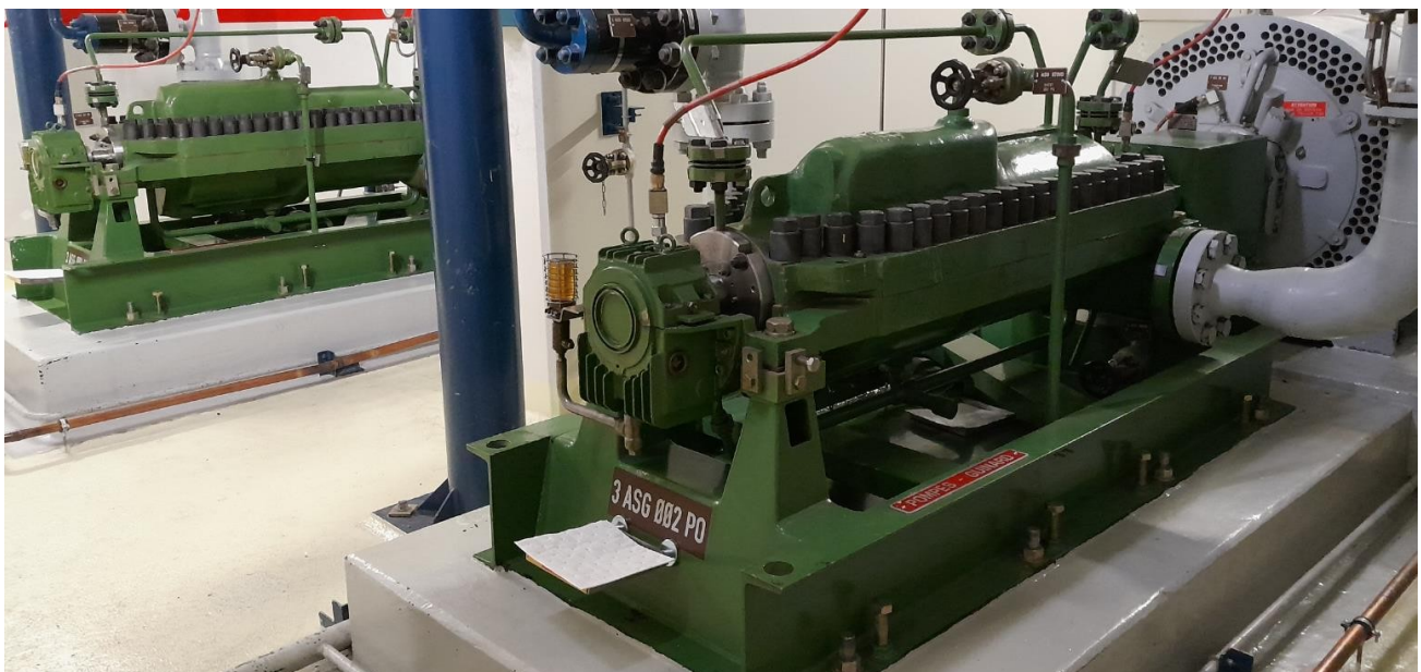
Motorpumpe für die Notwasserversorgung der Dampferzeuger (ASG)
