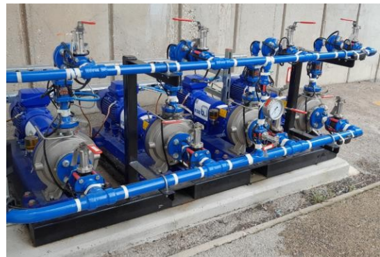
Druckerhöhungspumpen des Vernebelungssystems
